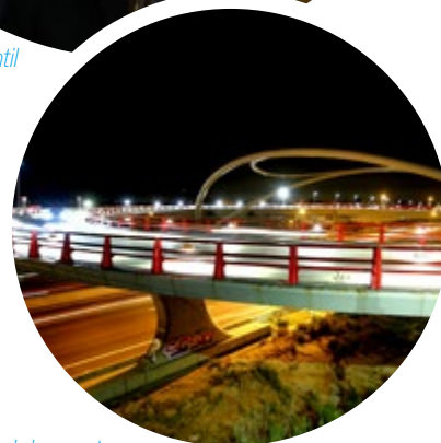
> Iluminación del puente de Las Matas
